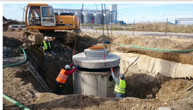
Figura 2.2 e 2.3 – Montagem do separador de hidrocarbonetos dentro do parque existente, incluindo escavação, laje de fundo, descarga do separador, aterro e reposição de pavimento
