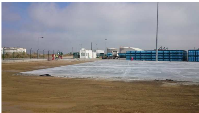
Figura 2.17 e 2.18 – Pavimentação em laje de betão
