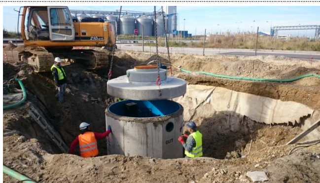
Figura 2.2 e 2.3 – Montagem do separador de hidrocarbonetos dentro do parque existente, incluindo escavação, laje de fundo, descarga do separador, aterro e reposição de pavimento
