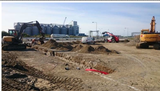
Figura 2.6 e 2.7 – Abertura de valas para redes de águas pluviais, combate a incêndio e rede elétrica de alimentação das colunas de iluminação
