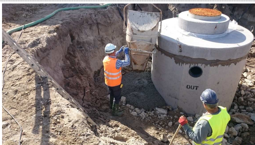
Figura 2.4 e 2.5 – Montagem do separador de hidrocarbonetos dentro do parque existente, incluindo escavação, laje de fundo, descarga do separador, aterro e reposição de pavimento
