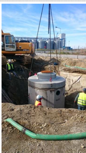
Figura 2.4 e 2.5 – Montagem do separador de hidrocarbonetos dentro do parque existente, incluindo escavação, laje de fundo, descarga do separador, aterro e reposição de pavimento
