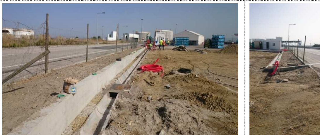
Figuras 2.15 e 2.16 – Execução da Rede de Drenagem
