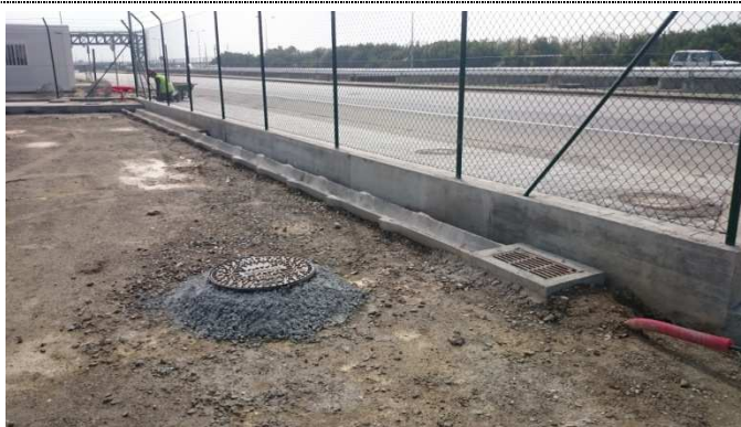
Figura 2.20– Finalização da rede de drenagem
