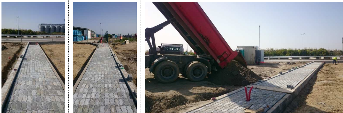
Figura 2.10, 2.11 e 2.12 – Execução de passeios exteriores e realização de terras escavadas
