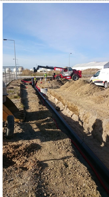
Figura 2.8 e 2.9 – Abertura de valas para redes de águas pluviais, combate a incêndio e rede elétrica de alimentação das colunas de iluminação
