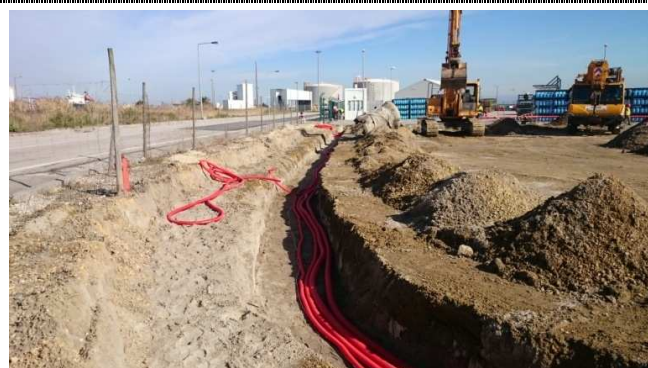
Figura 2.6 e 2.7 – Abertura de valas para redes de águas pluviais, combate a incêndio e rede elétrica de alimentação das colunas de iluminação
