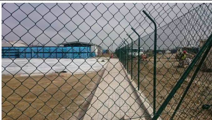
Figuras 2.23 e 2.24– Montagem de vedação em rede metálica
