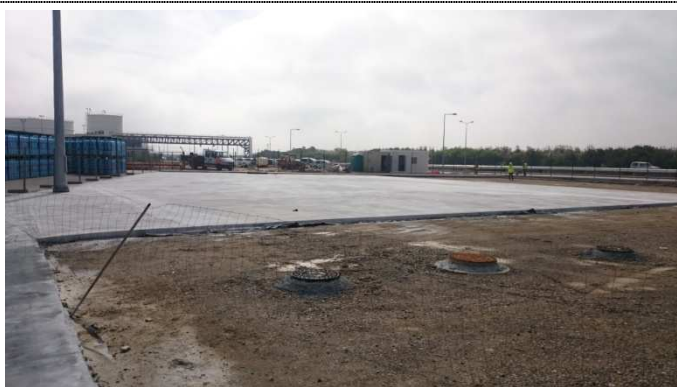
Figura 2.19– Pavimentação em laje de betão
