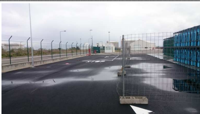
Figuras 2.25 e 2.26 – Pavimentação betuminosa da zona de circulação e execução de pinturas de pavimento
