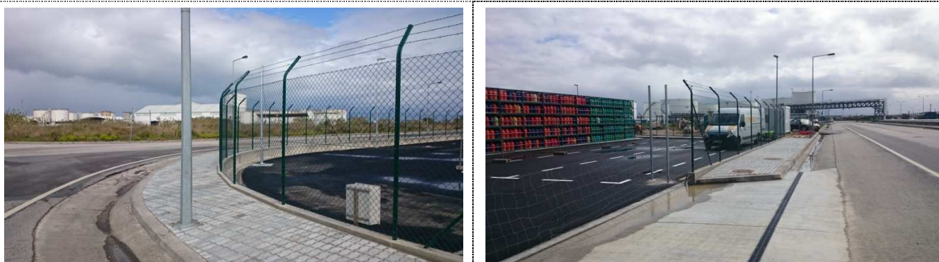
Figuras 2.35 e 2.36 – Finalização instalação de rede metálica e passeios exteriores
