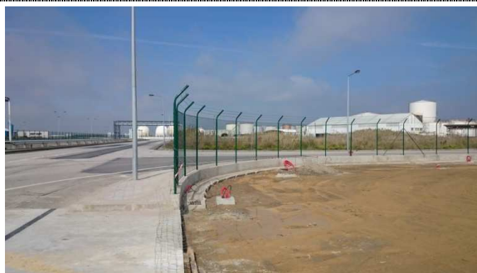
Figuras 2.23 e 2.24– Montagem de vedação em rede metálica
