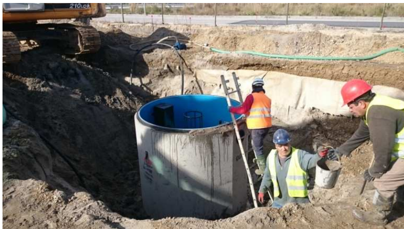
Figura 2.1– Montagem do separador de hidrocarbonetos dentro do parque existente, incluindo escavação
